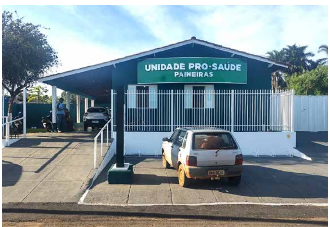
Fachada revitalizada da UBS Dr. José Carlos Rodrigues (bairro Paineiras)
