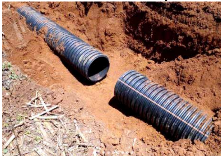
Instalação de interceptores de esgoto
