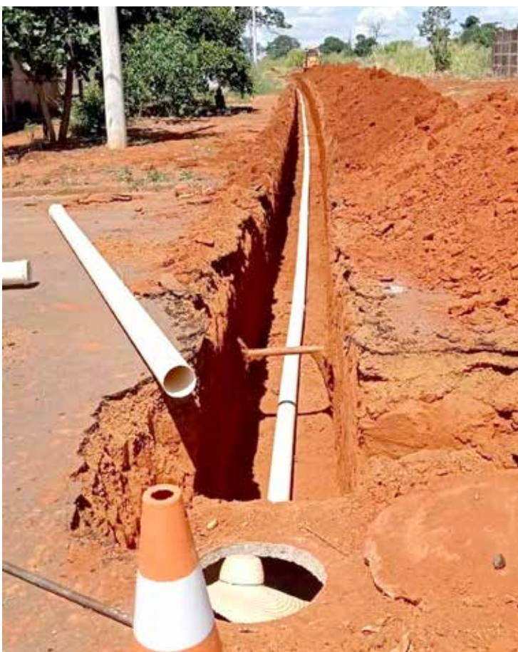
Rede coletora de esgoto sendo instalada no bairro Cynthia
