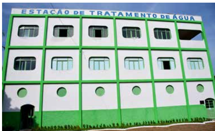
Instalações da Estação de Tratamento de Água totalmente reformadas
