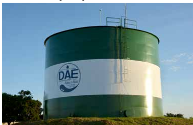
Reservatório de alta capacidade do DAE, reformado nes gestão
