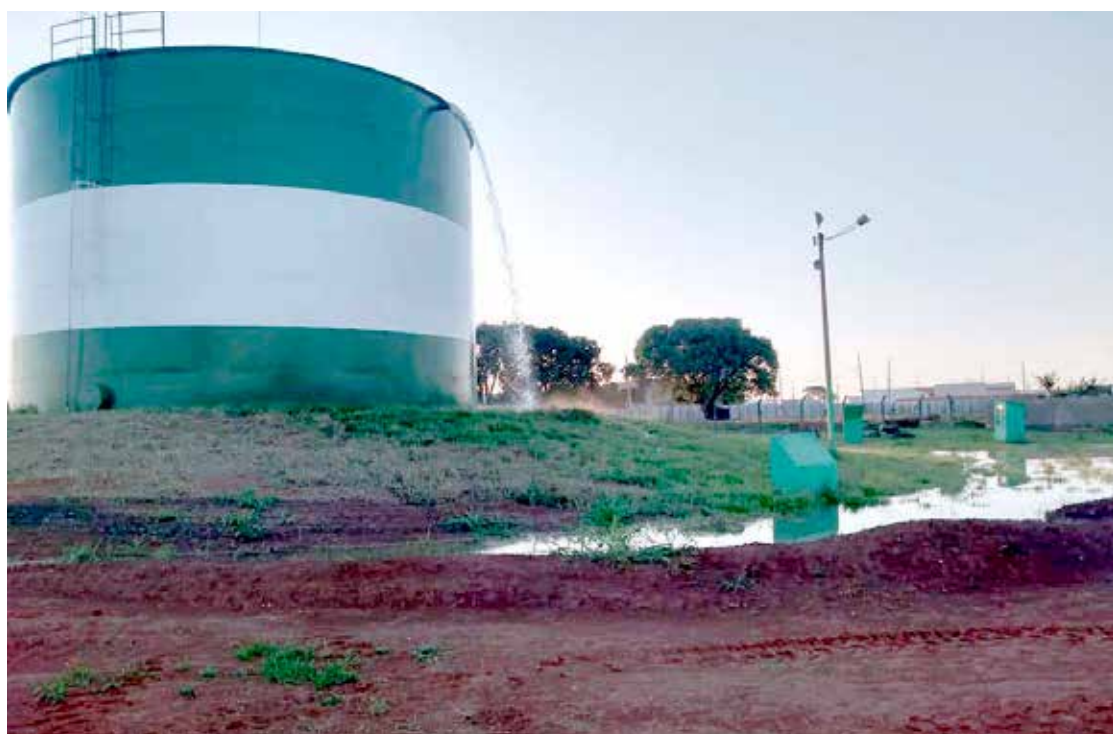
Para evitar que água possa descer cidade abaixo, fizeram uma barreira de contenção no terreno
