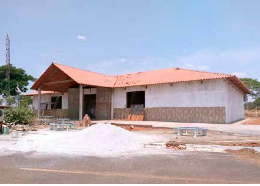
Centro de Eventos em fase de conclusão de suas obras
